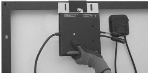
4. Con una chiave a bussola da 13 mm, serrare la vite fino a ottenere una coppia di 18 Nm.
