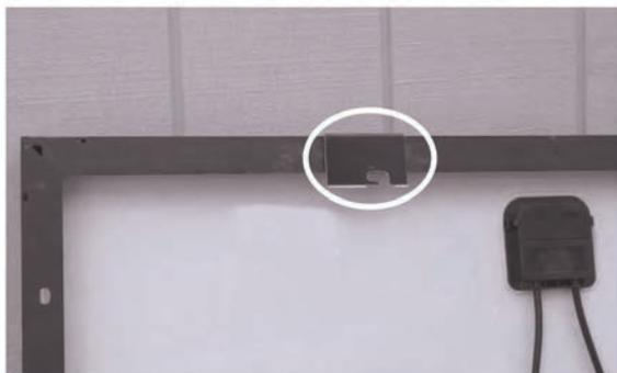
2. Avvitare la vite a testa esagonale nell'inserto filettato sulla staffa, quindi far scorrere l'asola del microinverter sulla vite.
